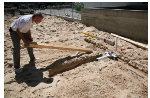
Jean-Luc installe les poteaux
